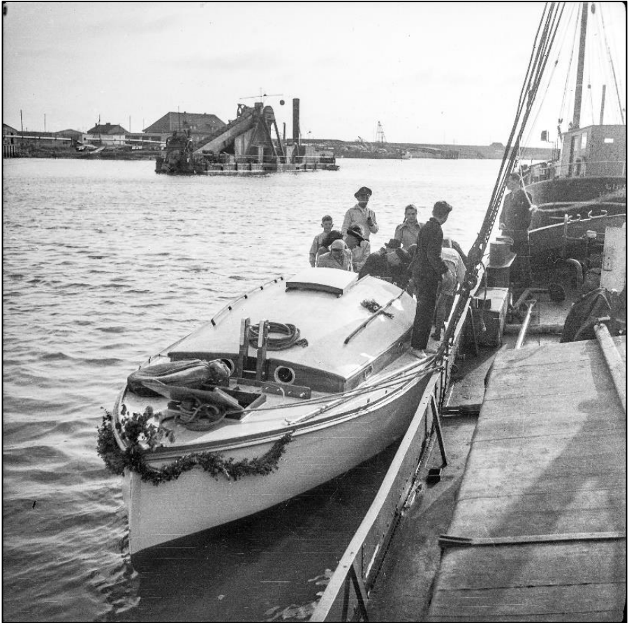
Im Hintergrund der Eimerkettenbagger. (Foto: Hella Bruhn).
