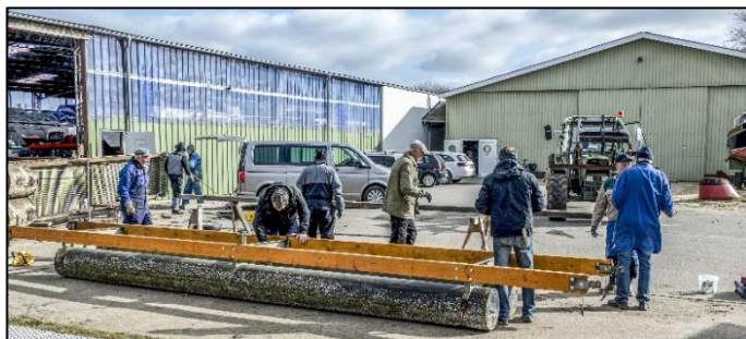
Brücken und Niedergänge reparieren.
