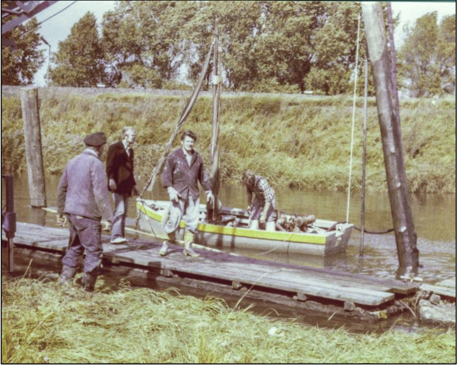
Vorarbeiten zum Hafenausbau: Wahrscheinlich spülen wir hier alte Dalben aus, um die Böschung frei zu machen. Dafür steht an Land der Demag-Kran des WSA. Personen von links: Heine Michelsen, Christoph Voigts, Günter Hirschbek, Jörgen Bruhn.
