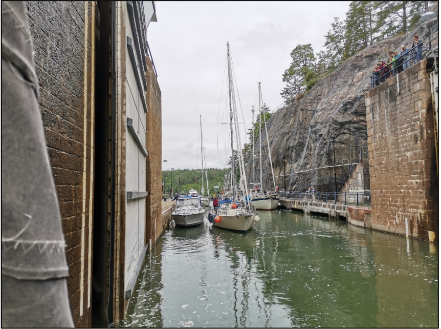
Treppenschleusung mit Gegenverkehr.
