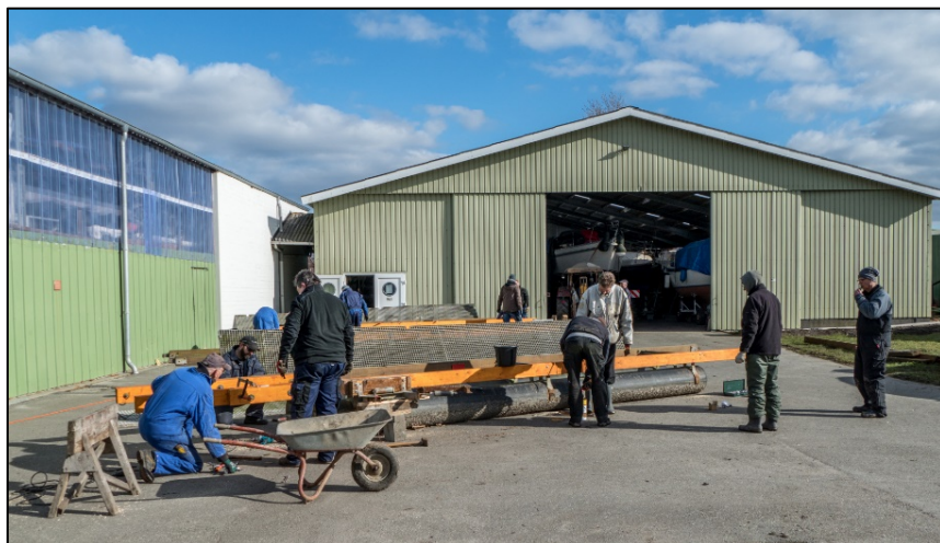
Brückenreparatur März 2022 (Foto: Uwe Paulsen/ Archiv HSrV).
