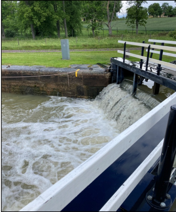
Schleuse nach Söderköping.
