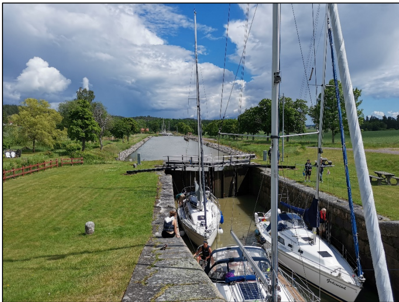
Vorbereitung zur Schleusung: "Alle fertig?"
