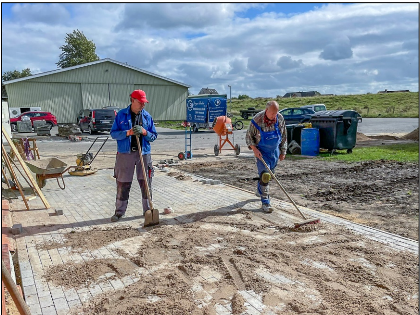
Pflastern des neuen Fahrradplatzes (Foto: Uwe Paulsen)
